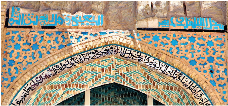
Fotoğraf 31: Battalgazi Ulu Camii avlu revakı ikinci kemer alınlığındaki kitabe
