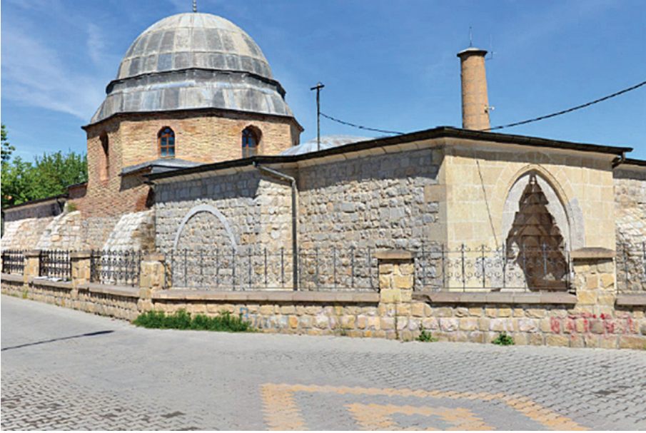
Fotoğraf 5: Battalgazi Ulu Camii güneybatı cephe
