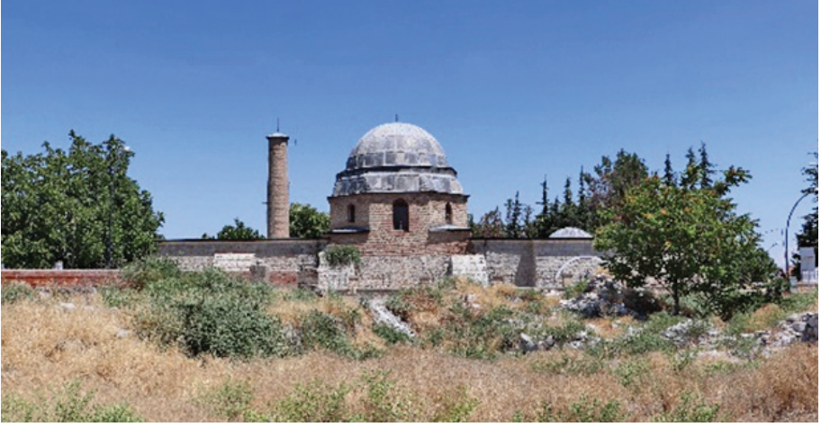
Fotoğraf 3: Battalgazi Ulu Camii güney cephe
