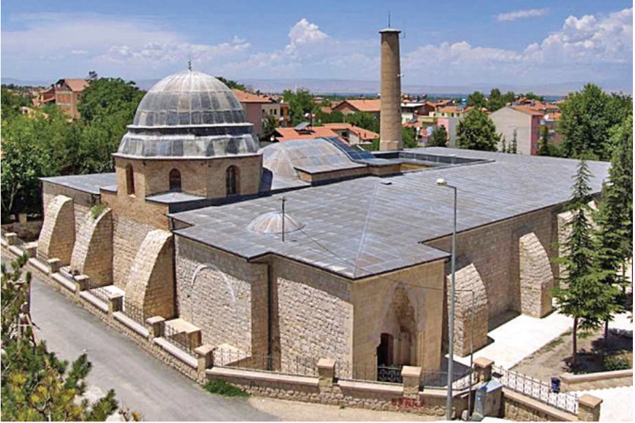
Fotoğraf 4: Battalgazi Ulu Camii güneybatı cephe
